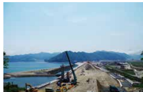
▲釜石市沿岸部の防潮堤工事風景。穏やかな海が広がる景色は、かなり高い場所からしか眺めることが出来ない。
